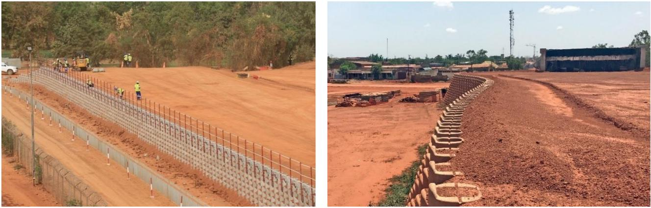
Figure 6. Flexibilité géométrique du système de parement, droit ou incurvé
