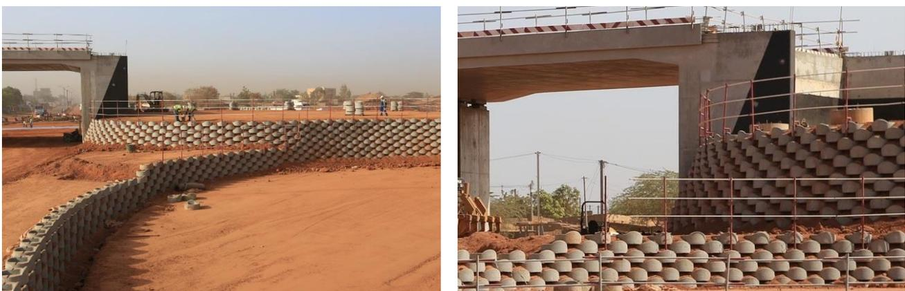
Figure 8. Jonction de deux murs renforcés et raccordement à un ouvrage d'art
