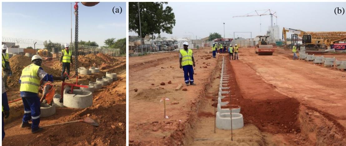
Figure 4. (a) Eléments de parement (b) Première rangée à la base
