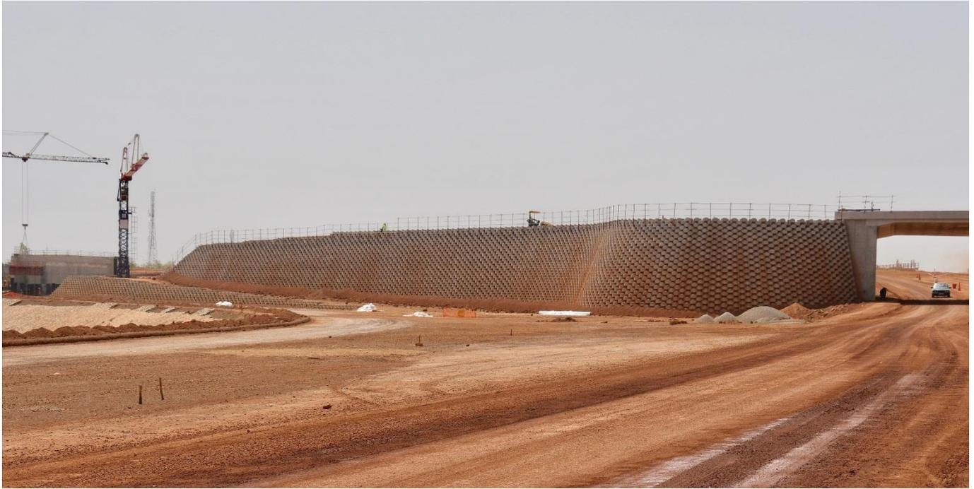
Figure 9. Remblai renforcé terminé
